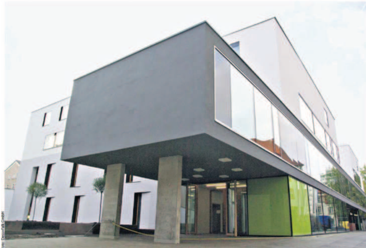
Im Auftrag des Staatlichen Bauamtes Bamberg plante und realisierte das Nürnberger Ingenieurbüro Dess+Falk die Heizungs-, Lüftungs- und Sanitärtechnik für zwei neue Hörsaal- und Institutsgebäude der Universität Bamberg.
