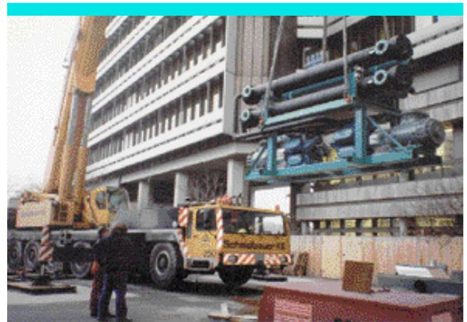
Bild 5: Ammoniak-Kältemaschine bei der Einbringung
